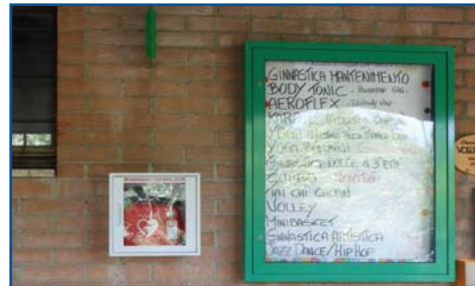
Il defibrillatore installato all'esterno della palestra comunale
