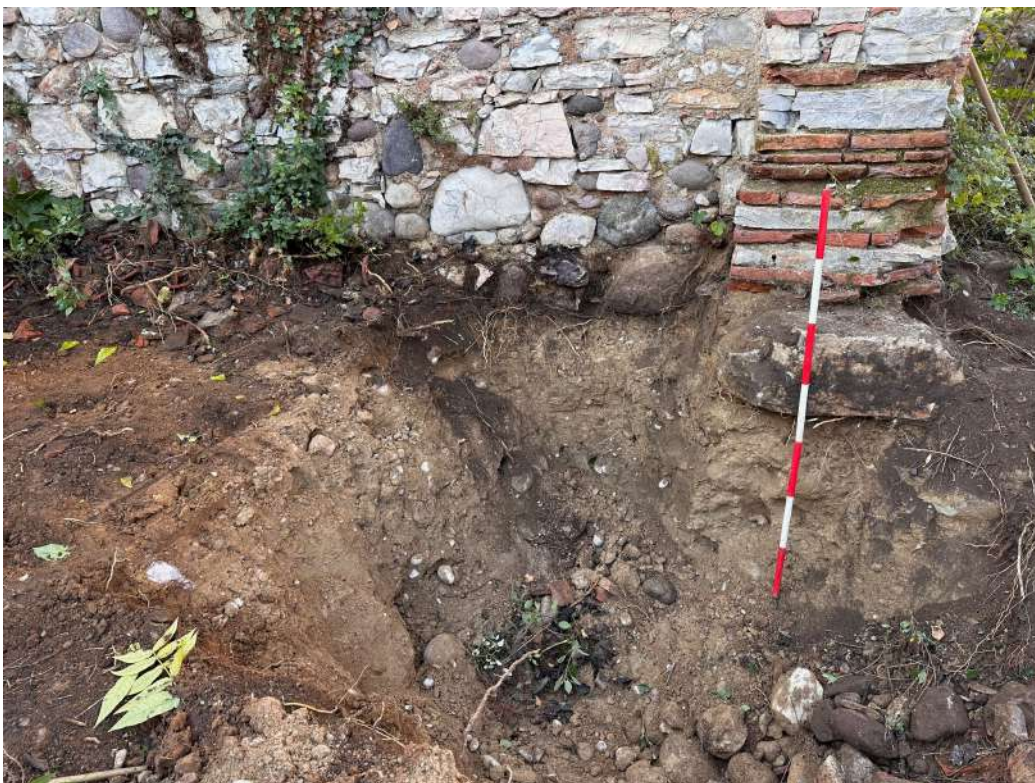
SONDAGGIO 8 – LA FONDAZIONE DEL PERIMETRALE EST DELLA CHIESA SI APPOGGA DIRETTAMENTE SUL TERRENO NATURALE
