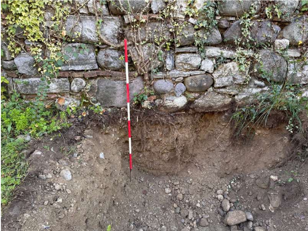
SONDAGGIO 3: LA FONDAZIONE DELL'EDIFICIO, POGGIA DIRETTAMENTE SUL TERRENO LIMOSO NATURALE CHE COPRE IL TERRENO STERILE
