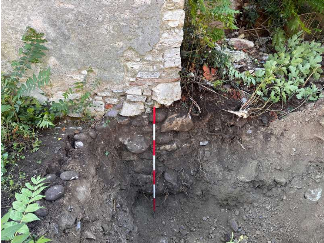
SONDAGGIO 7 – FONDAZIONE DELLA TESTATA PRESBITERIALE DELLA CHIESA
