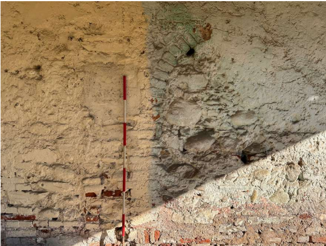
PORTALE TAMPONATO NEL PERIMETRALE SUD DEL CORPO DI FABBRICA OCCIDENTALE, LA PRESENZA DEL BARDELLONE AL DI SOPRA DELLA GHIERA DELL'ARCO POTREBBE INDICARE UNA FASE PIÙ ANTICA DI QUESTA PARTE DEL COMPLESSO
