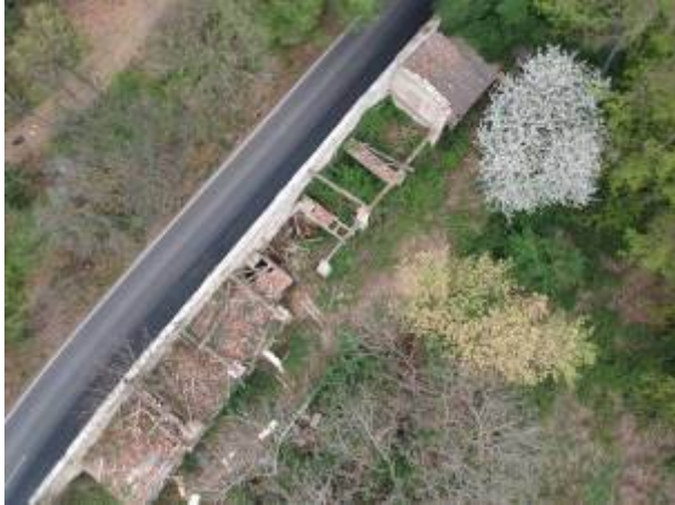
RILIEVO FOTOGRAFICO STATO DI FATTO
