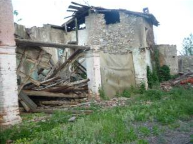
RILIEVO FOTOGRAFICO STATO DI FATTO
