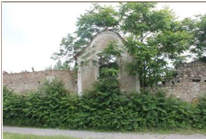
RILIEVO FOTOGRAFICO STATO DI FATTO
