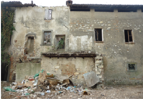
RILIEVO FOTOGRAFICO STATO DI FATTO
