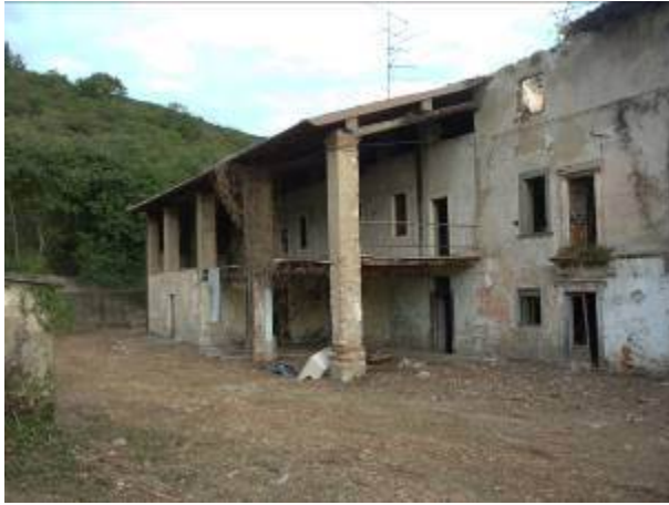
RILIEVO FOTOGRAFICO STATO DI FATTO
