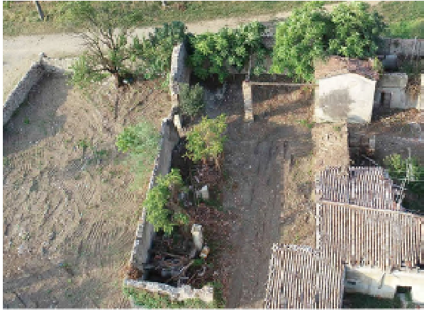
RILIEVO FOTOGRAFICO STATO DI FATTO
