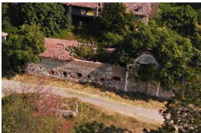
RILIEVO FOTOGRAFICO STATO DI FATTO
