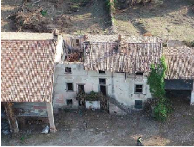
RILIEVO FOTOGRAFICO STATO DI FATTO
