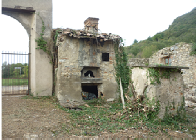
RILIEVO FOTOGRAFICO STATO DI FATTO
