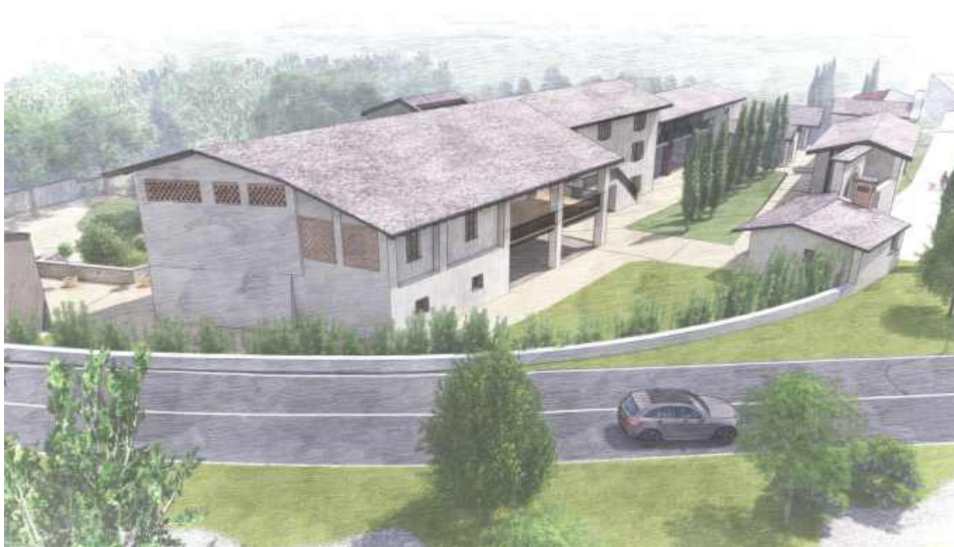
Fabbricato forno e corpo ovest – vista dalla strada
