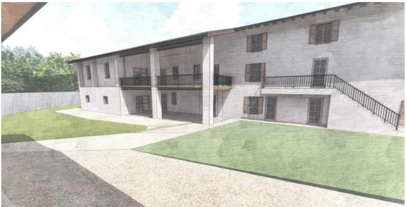
Fabbricato centrale e ovest - vista fronte in affaccio sulla corte
