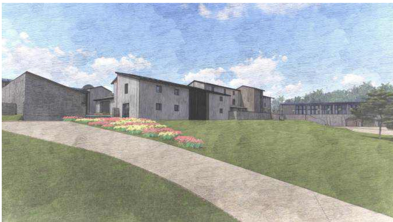
Fabbricato est - vista fronte in affaccio sul giardino con rimodulazione delle aperture e copertura con fotovoltaico in falda nord
