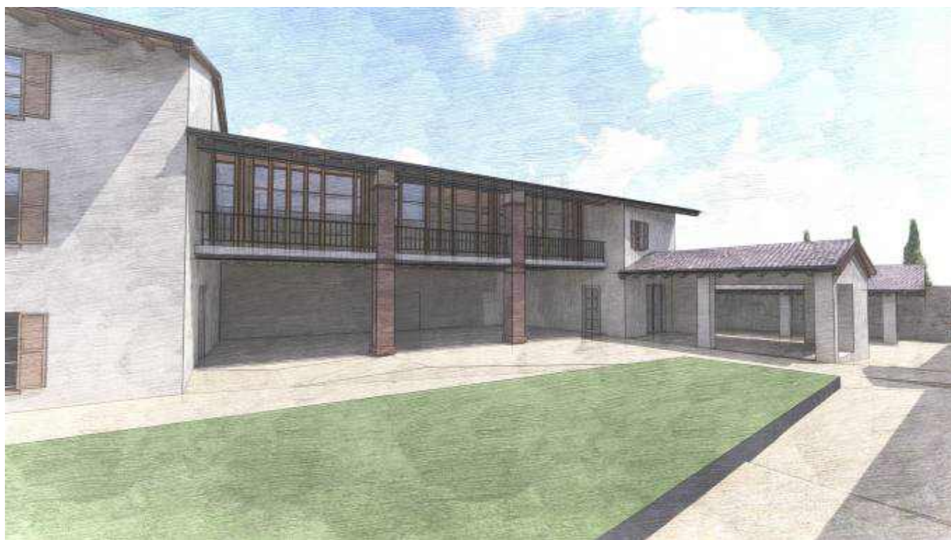
Fabbricato est - vista fronte in affaccio sulla corte con chiusura del loggiato con serramento a tutta altezza
