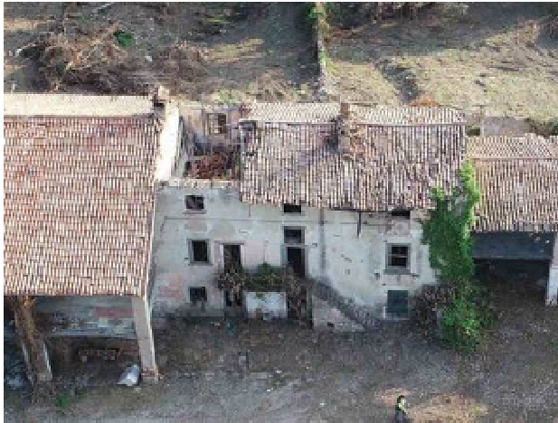
RILIEVO FOTOGRAFICO STATO DI FATTO
