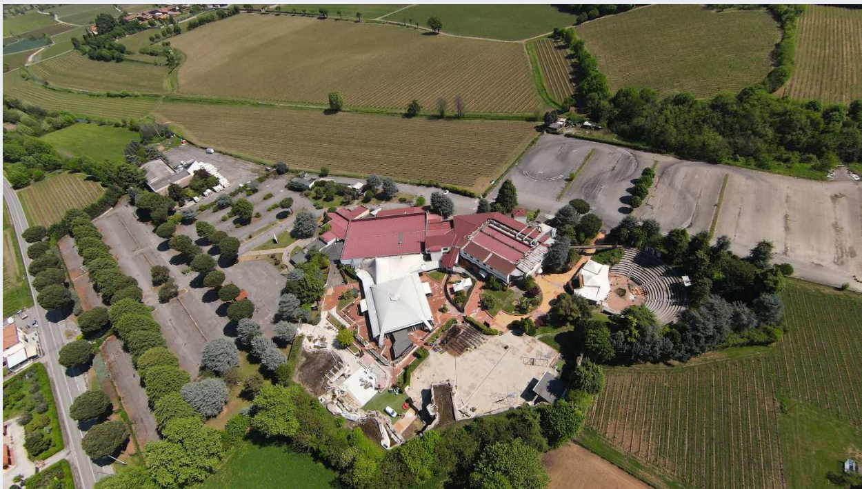
Vista aerea stato di fatto — ex discoteca «Number One» e aree pertinenziali (inserire ortofoto/foto da drone)
