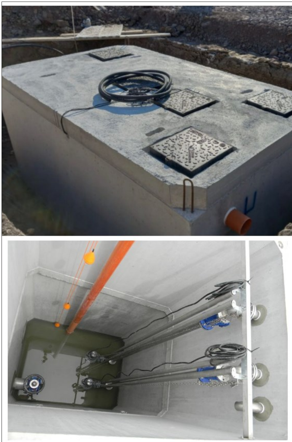
Fig. 19 - Vasca di laminazione in c.a. realizzata in opera con doppio sistema di pompe ad innesco.
