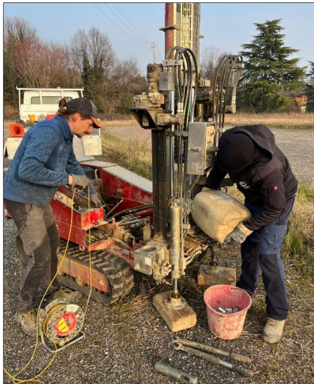
Fig. 9 - Fasi di esecuzione della prova di permeabilità Pk2 presso il sito di indagine.
